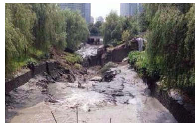
7.31 杭州施工塌陷事故
