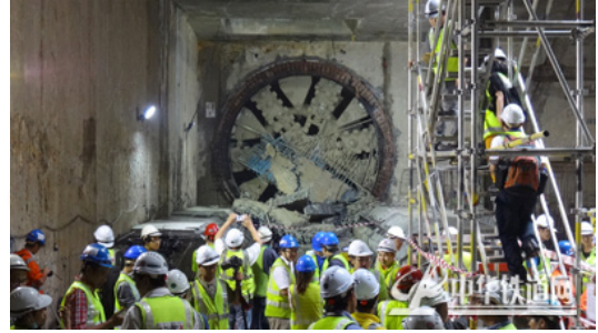
图55 马来西亚第一地铁盾构区间隧道施工 图片来源：中华铁道网
