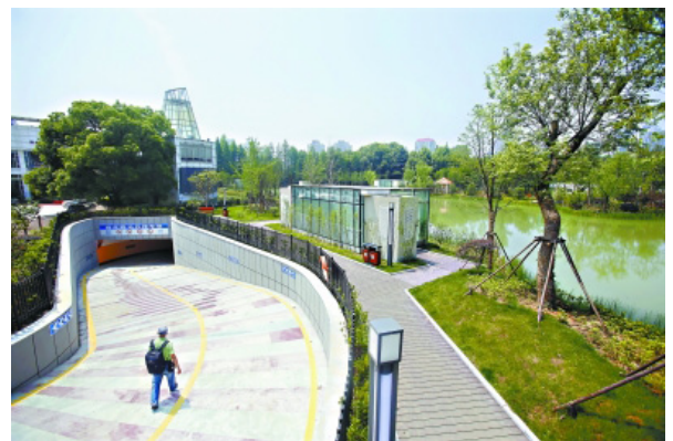
武汉水下停车场出入口实景
