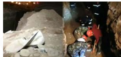
4.28 兰州地铁工地塌方事故
